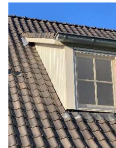
Aansluiting dakkapel aanpassen door verholen goot
